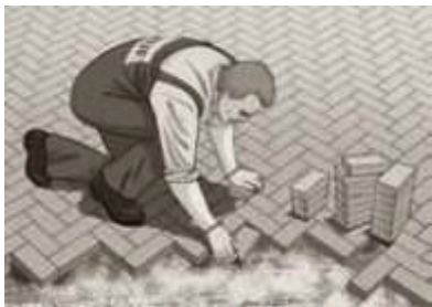
Мощение поверхности с формированием узора «елочка».
