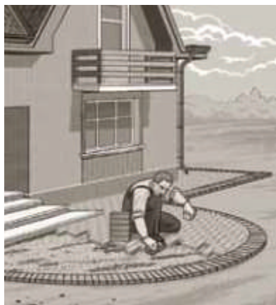
Укладка очередных рядов клинкерной брусчатки.
