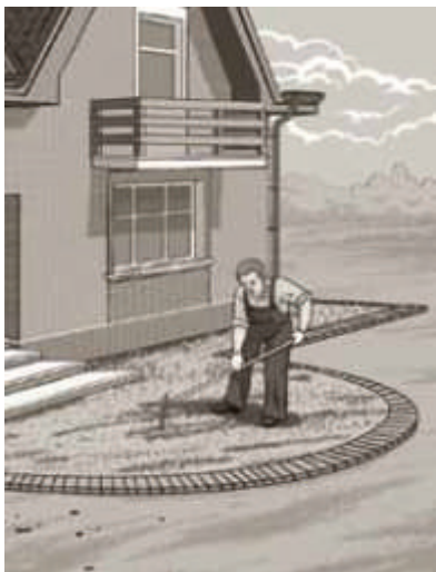
Укладка очередных рядов клинкерной брусчатки.
