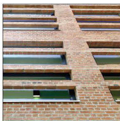
Den afsluttende fuge i de præfabrikerede lameller er udført på stedet for at få samme farve som husets øvrige fugearbejder i krydsforbandterne.
