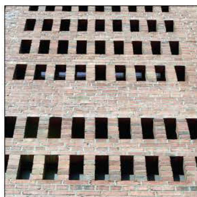
Filigranmurværket er principielt brugt ved trappeopgange for dels at sikre lys på trappen uden at give køb på en vigtig afskærmning.
