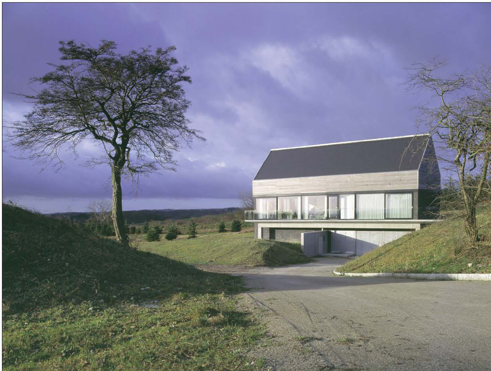
Familiehuset i Malling for familien Stitz er opført med facader af Petersen Tegl Egersund D55: "Det rå terræn, mulden og mudderet betinger materialevalget, rustikt, stofligt og rå," forklarer Claus Hermansen.
