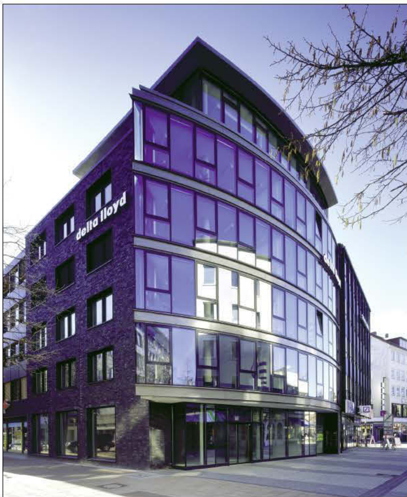
Kontorhuset i Hannover har en sektion med butikker i parterre etagen. Etagen er trukket tilbage i forhold til glasbuen. Ide: KSP Engel & Zimmermann.
