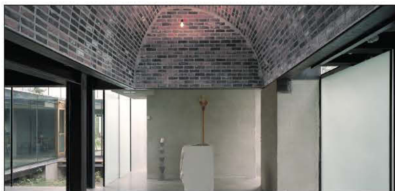
En mangfoldighed af gennemførte og værdige materialer omfatter også klinken Petersen Tegl Egernsund D55 til murede hvælvinger.
