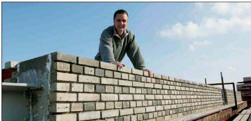
Ingeniør Steen Spang Hansen, PM Tegl ved teglbjælker til Frederiksberg Gymnasium med arkitektur af Henning Larsens Tegnastue. Dimensionerne er imponerende: 60x60x6000 cm. Vægt pr. stk.: 5 ton.
