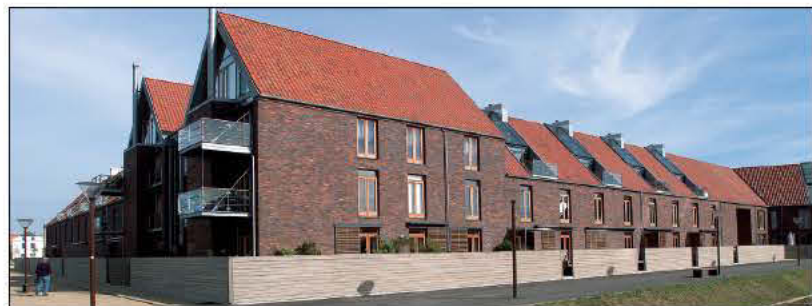
Amsterdamhusene, et boligbyggeri af Arkitektgruppen Aarhus med Petersen Tegl Egernsund D48 med indfarvede fuger.
