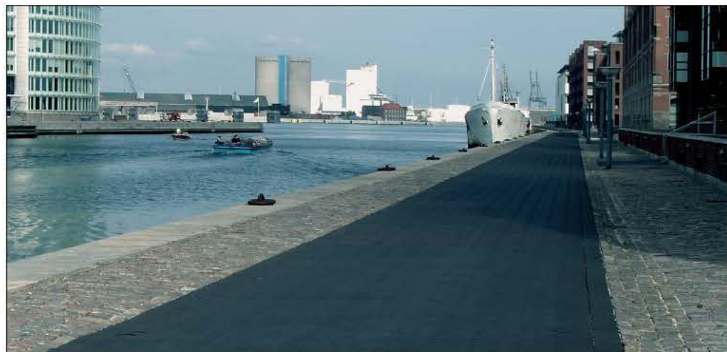
Flot view ned ad kajen ved Amerika bassinet. Boldsen & Holm har designet belægningsmønsteret i sildeben. Indramning i granit.
