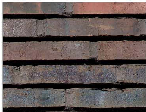
D48. Rigdom i detaljen – med og uden udskrabt fuge.
