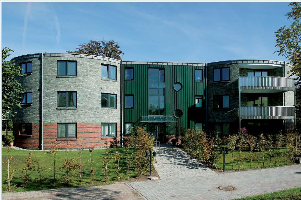
Facaden mod Uferstrasse med de to tårne, forbundet af mellembygningens træbeklædning. Her findes hovedtrappe og elevator. Arkitektur: Willem Hain Architektbüro.
