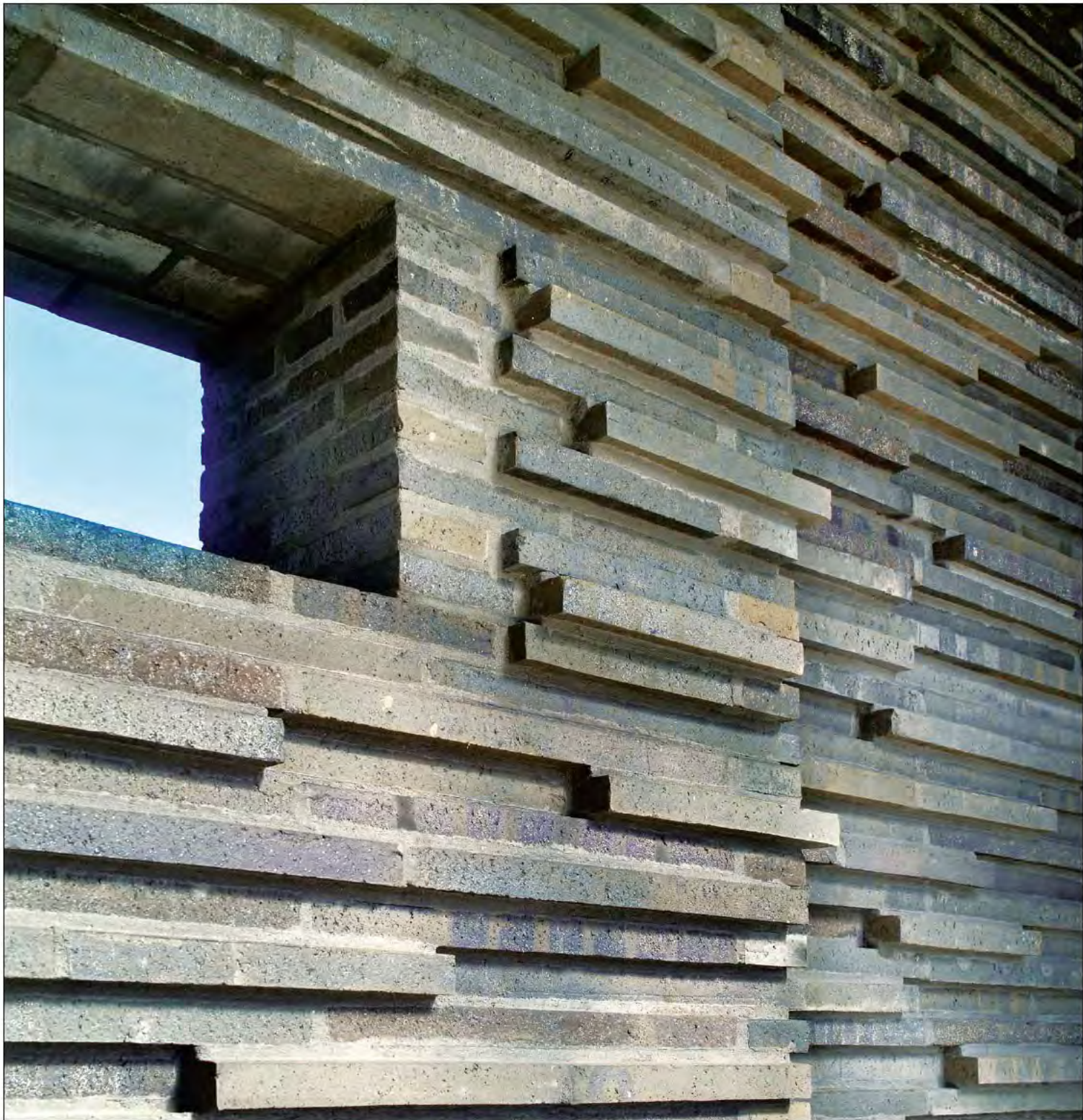
MURVÆRK, DER VIL REVOLUTIONERE OPFATTELSEN AF DET MUREDE HUS: MURERE FRA MURBO A/S HAR UDFØRT TEGNINGERNE FRA LUNDGAARD & TRANBERG MED KOLUMBA STEN FRA PETERSEN TEGL EGERNSUND A/S
