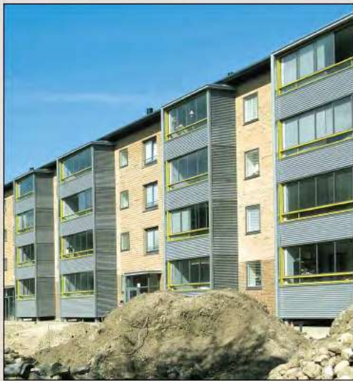
DOMUS ARKITEKTER HAR TILFØRT BYGGERIET EN NY PERSONLIGHED VED BL.A. AT ANVENDE RELIEFMURVÆRK MED FREMSKUDTE SKIFTER.
