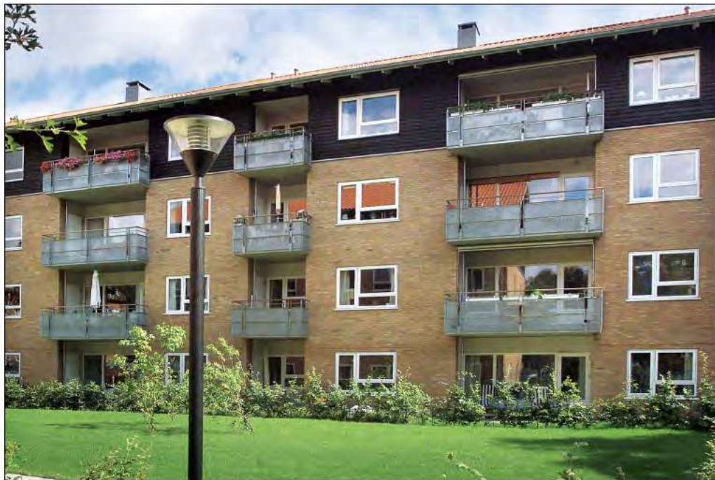
TOP: GADEKÆRET ER ET BOLIGPROJEKT I VALBY FOR PROJEKTUDVIKLEREN FRIHEDEN BOLIG: 27 ANDELSBOLIGER I STØRRELSER FRA 70-122 M 2 SAMT ENKELTE BUTIKSLEJEMÅL. FACADER MED PETERSEN Tegl EGERNSUND D33. MANNIK & STORM 2004.
