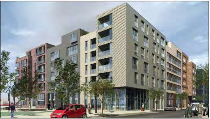
HJØRNEEJENDOM MED PROFILMURVÆRK OG LOGGIA-ALTANER. MURKLINKE: PETERSEN Tegl D78. TIL VENSTRE ET LORENZEN-PROJEKT MED MURVÆRK AF PETERSEN Tegl KOLUMBA.
