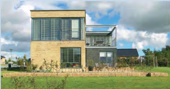
FAMILIENS HUS ER OPFØRT MED FULDMUREDE FACADER AF TO TYPER PETERSEN Tegl, D31 OG D58. HAVENS BELÆGNINGER MED PETERSEN PM KLINKER ER SAMMEN MED TIL AT REDUCERE SKALAEN.
