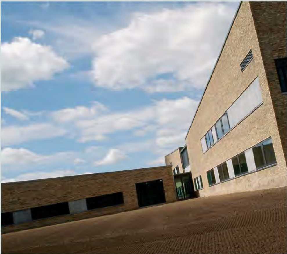
PERIMETER MURENS BEVÆGEDE FORLØB GIVER DET SAMLEDE ANLÆG LANDSKABELIG LETHED OG NEDTONER DET MONUMENTALE PRÆG. TV: MURVÆRKET OPTRÆDER I SAGENS NATUR I UDSTRAKTE, LUKKEDE AFSNIT. FRIIS & MOLTKE ØNSKED FLADER MED FARVESPILE MED ET NEDTONET FUGEMØNSTER. HERUNDER: FRIIS & MOLTKE ØNSKED ET MURVÆRK, DER HARMONEREDE MED LANDSKABETS GYLDE OG BRUNE FARVER PÅ ENNER MARK OG VALGTE PETERSEN TEGL D32. FOTO: SØREN NIELSEN.
