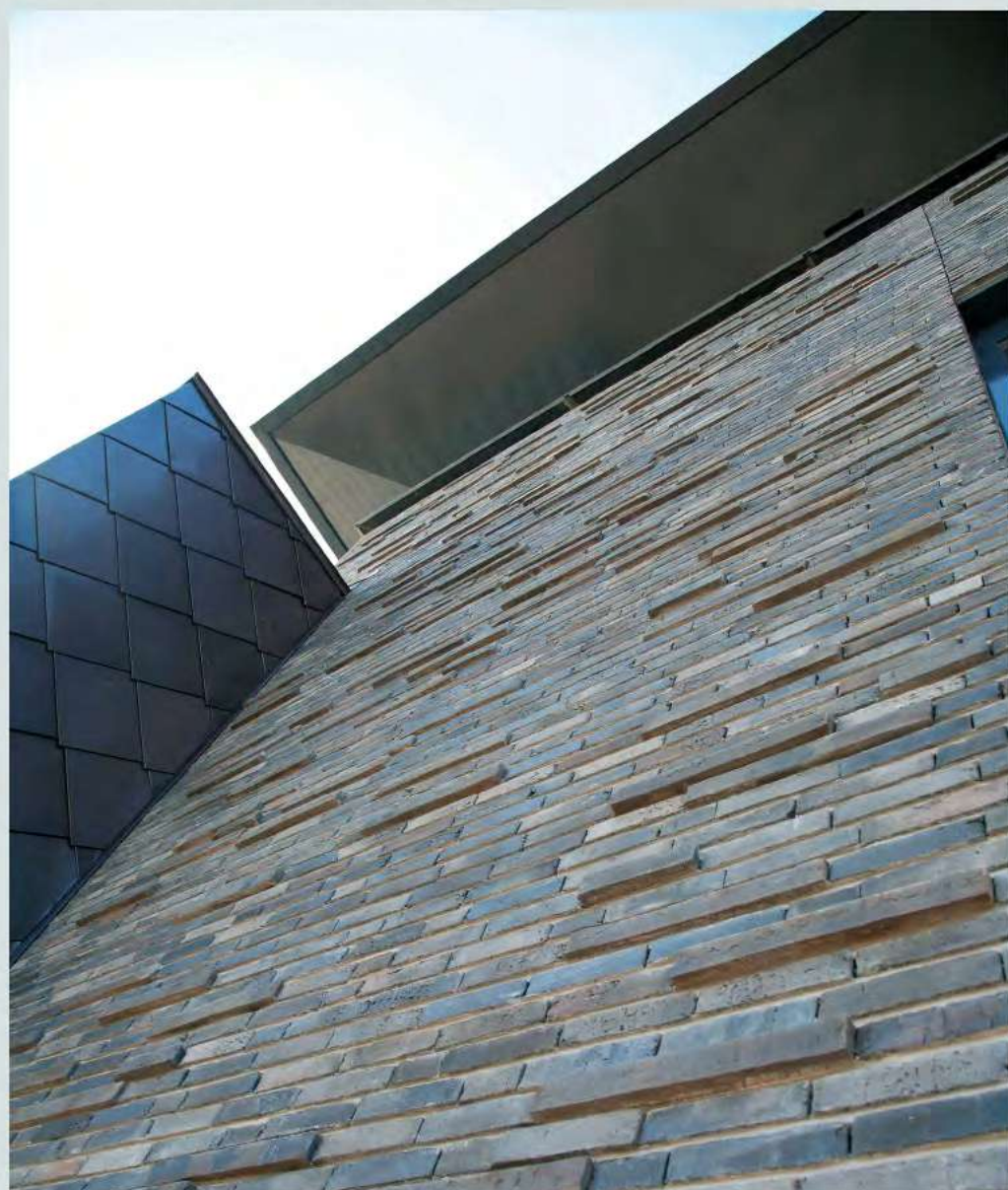
I ET MURVÆRK MED PETERSEN Tegl D55 ER INDSAT PUNKTVISE KOLUMBA™ STEN, FREMSKUDT SOM RELIEFFER.
