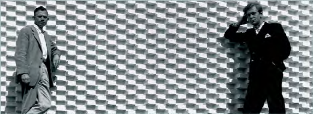
JØRGEN BO (TH) OG VILHELM WOHLERT VED HOVEDVÆRKET LOUISIANA. MURVÆRK I SAVTAKSFORBANDT
