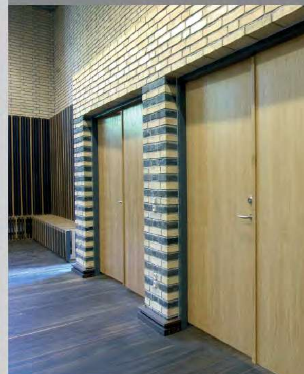
SKOLEN PÅ KASTELSVEJ HAR FÅET EN NY MUSIKSAL EFTER ET PROJEKT AF NOVA 5 ARKITEKTER. MURVÆRK: PETERSEN Tegl D55. INDE I SALEN ER DER STÆRKE VISUELLE SIGNALER MED FLETMURVÆRK AF GULE OG SORTE MURSTEN.
