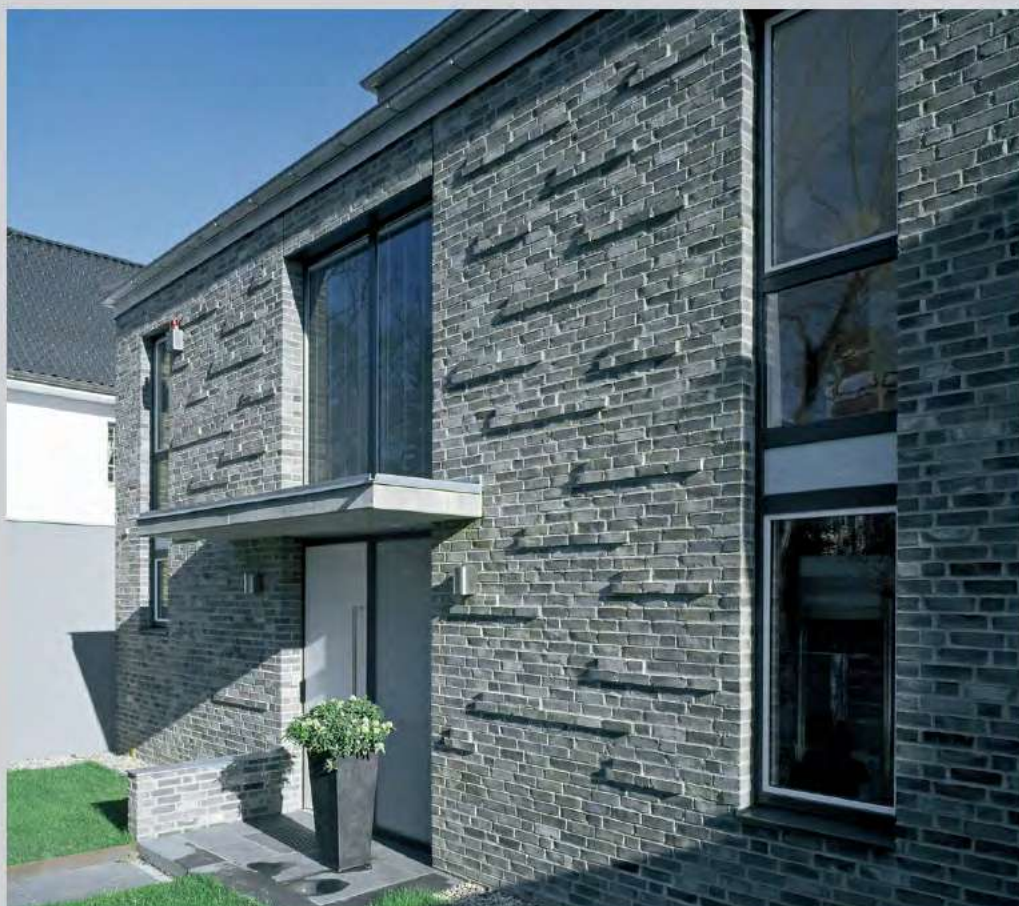
ZEHLENDORF: MOD GADEN OG HOVEDADGANGEN TIL HUSET ER MURVÆRKET I PARTIER ARTIKULERET MED FREMSPRINGENDE STEN – EN UNDERSTREGNING AF STENENS REFERENCER TIL NATURSTEN OG KLIPPEFORMATIONER.
