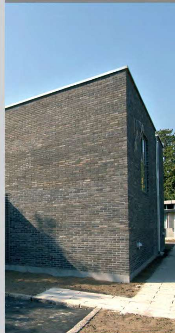
ZEHLENDORF: MOD GADEN OG HOVEDADGANGEN TIL HUSET ER MURVÆRKET I PARTIER ARTIKULERET MED FREMSPRINGENDE STEN – EN UNDERSTREGNING AF STENENS REFERENCER TIL NATURSTEN OG KLIPPEFORMATIONER.
