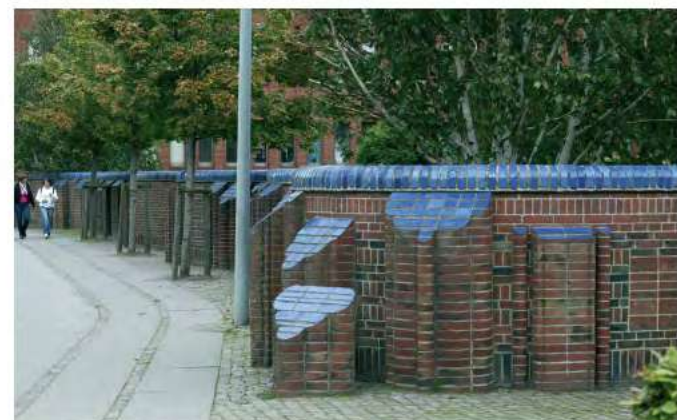
TELEMUREN I AABENRAA FRA 1993 ER FORTSAT ULLA VIOTTIS STØRSTE MUREDE SKULPTUR. DEN ORGANISK BØLGENDE MUR, DER OPRINDELIGT BLEV UDFØRT TIL TELE SØNDERJYLLAND, REGIONALT TELEFONSELSKAB, ER 60 M LANG OG 1,75 M HØJ.
