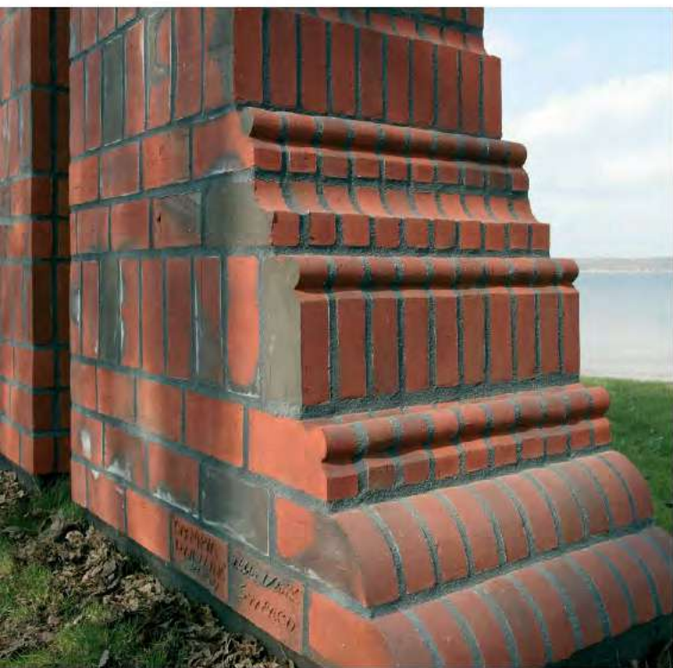
ØVERST: 1991: ULLA VIOTTIS 'ENERGI' ER ET RELIEF FRA 1991 TIL MALMÖ ENERGIVERK, NU EON. INSPIRATIONEN KOM BL.A. FRA ENERGIVÆRKETS RØRLEDNINGER TIL NATURGAS. OPGAVER BLEV BEGYNDELSEN TIL VIOTTIS LANGE VENSKAB MED PETERSEN TEGL A/S.
