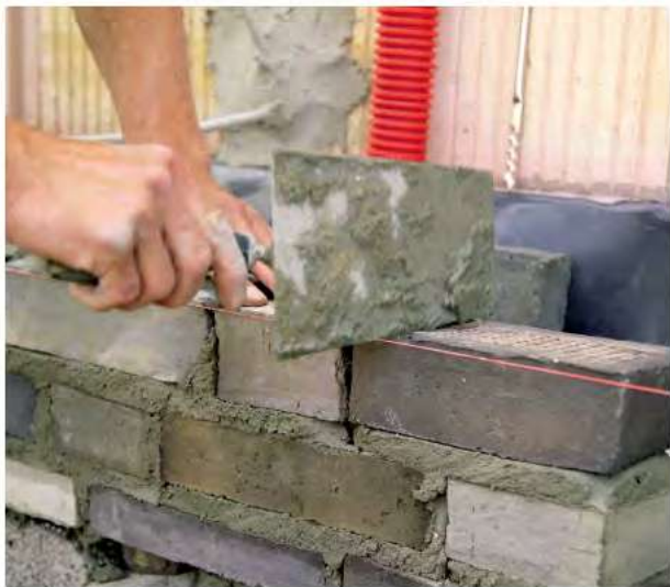
Murerhåndværk på toppen: Muring med flere formater på en bagmur af isolerende teglblokke fra Wienerberger.
