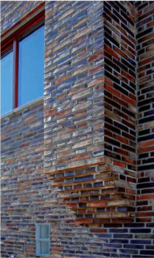
Murværk med håndværksmæssige kvaliteter: En skorsten er ikke bare tilføjet huset, men masseres ud af murværket i trapper.
