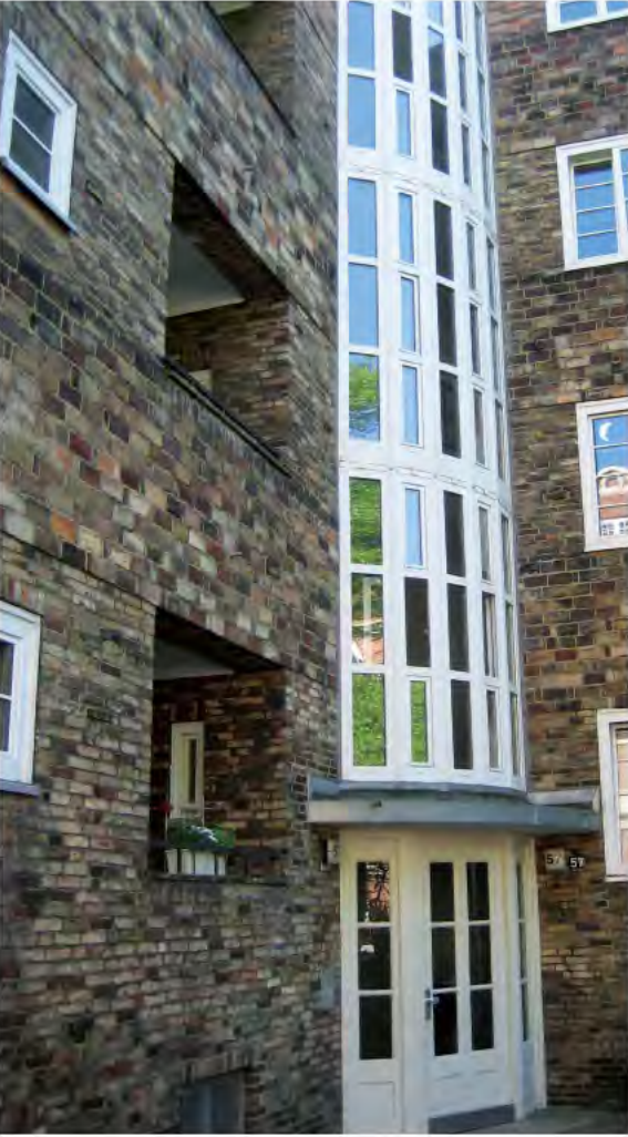
Boligbyggeri i Altonas Schützenstrasse, tegnet af Gustav Oelsner i 1928: Murværk med sublim detaljerigdom.
