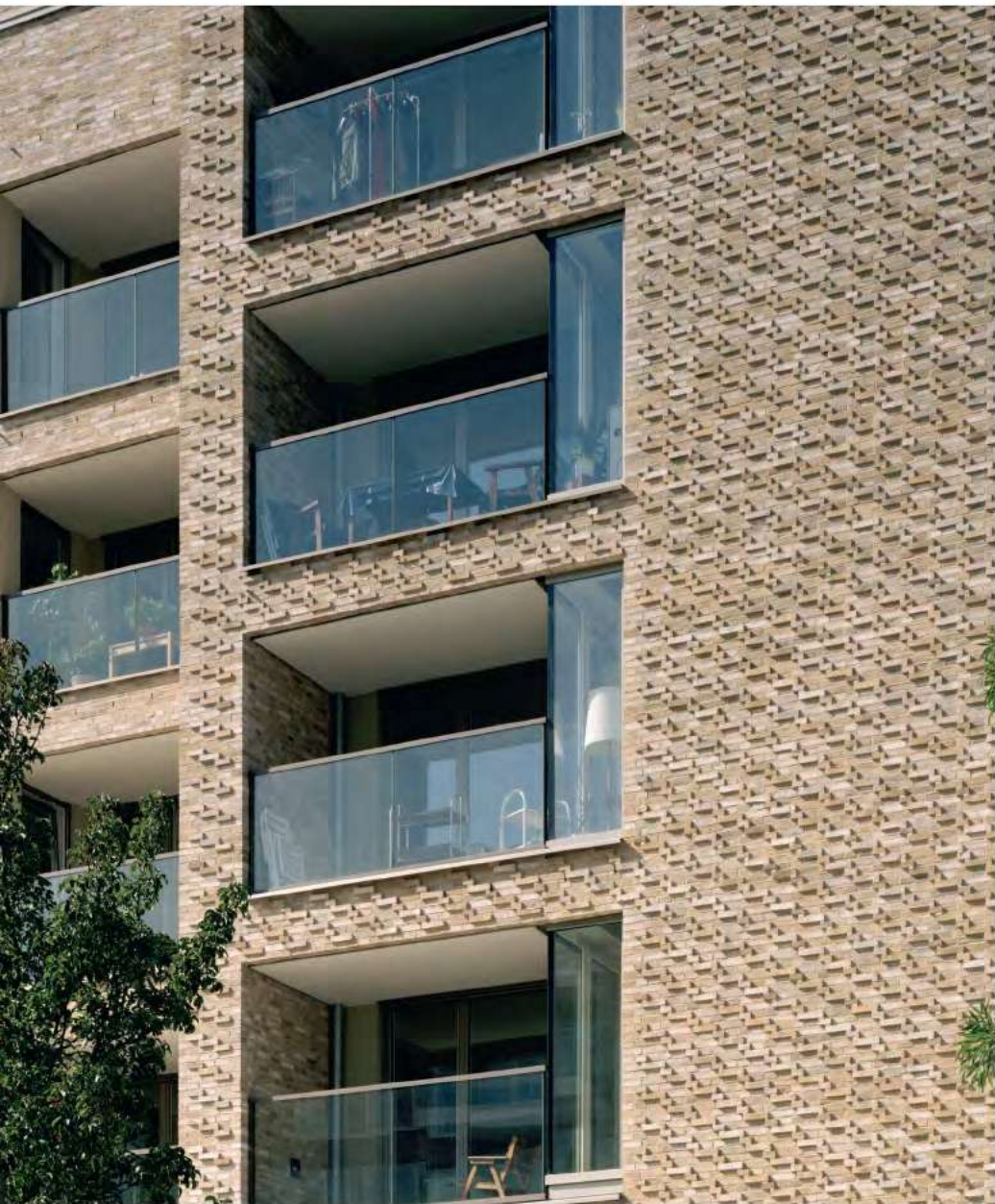
Figurmurværket er simpelt udført ved at trække sten frem i den skalmurede facade, men effekten er kolossal.
