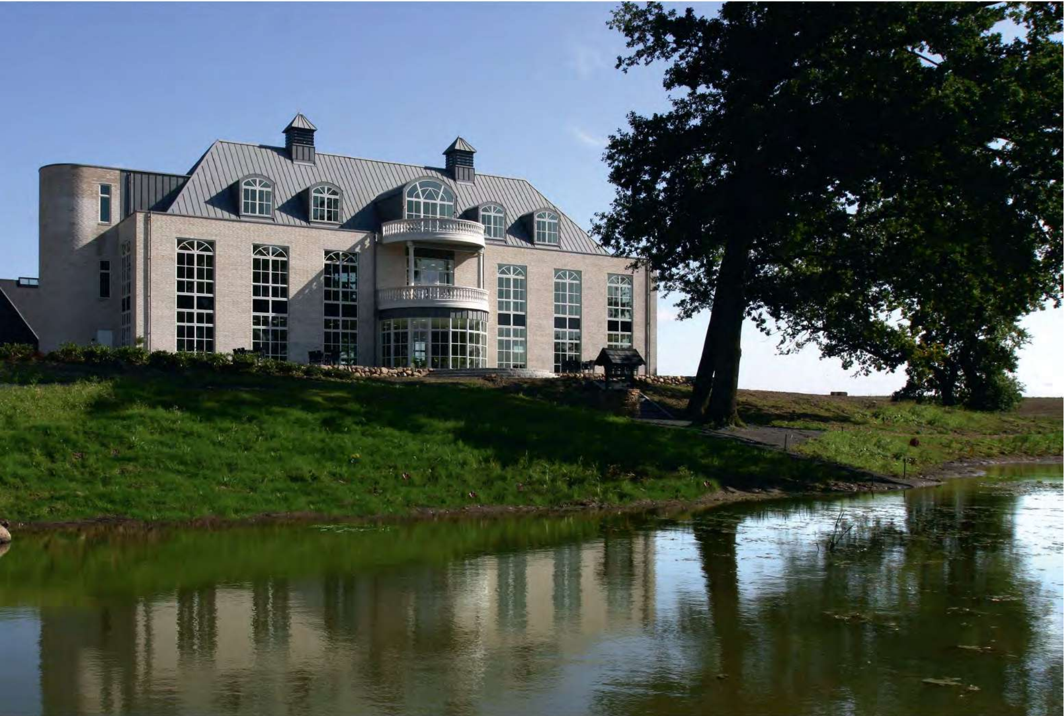
Me Too residerer bag disse imponerende mure, der dog ikke er helt så tykke som de synes. Der er skalmuret på betonkonstruktioner med Petersen Tegl D71. | Foto: Thomas Mølvig
