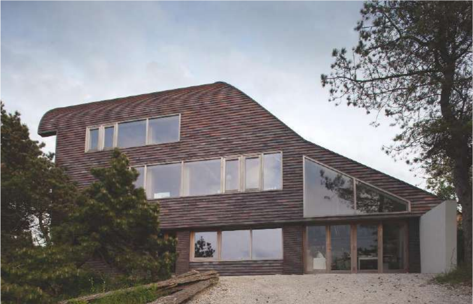
Specialudgaven af Kolumba er monteret på højkant som både facade- og tagbeklædning.
