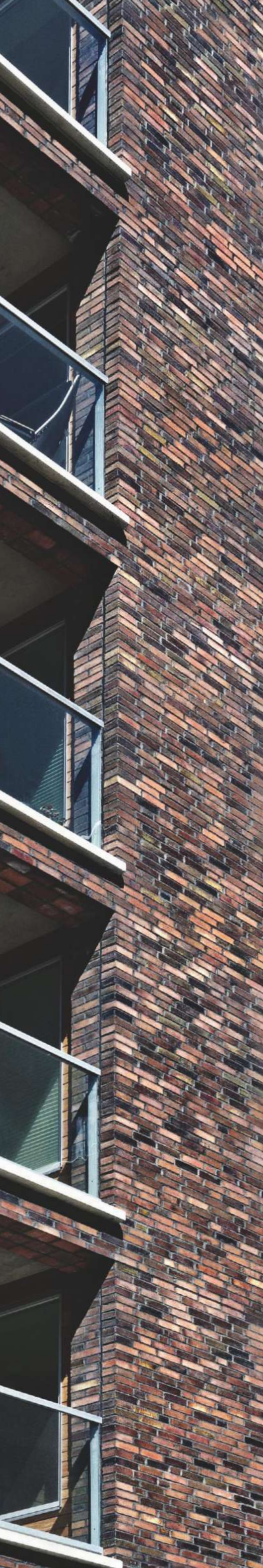
Den mørkegrå fuge giver murværket den ønskede mørke karakter. I de to underste etager er skalmuren udført med et relief, som markerer husets base
