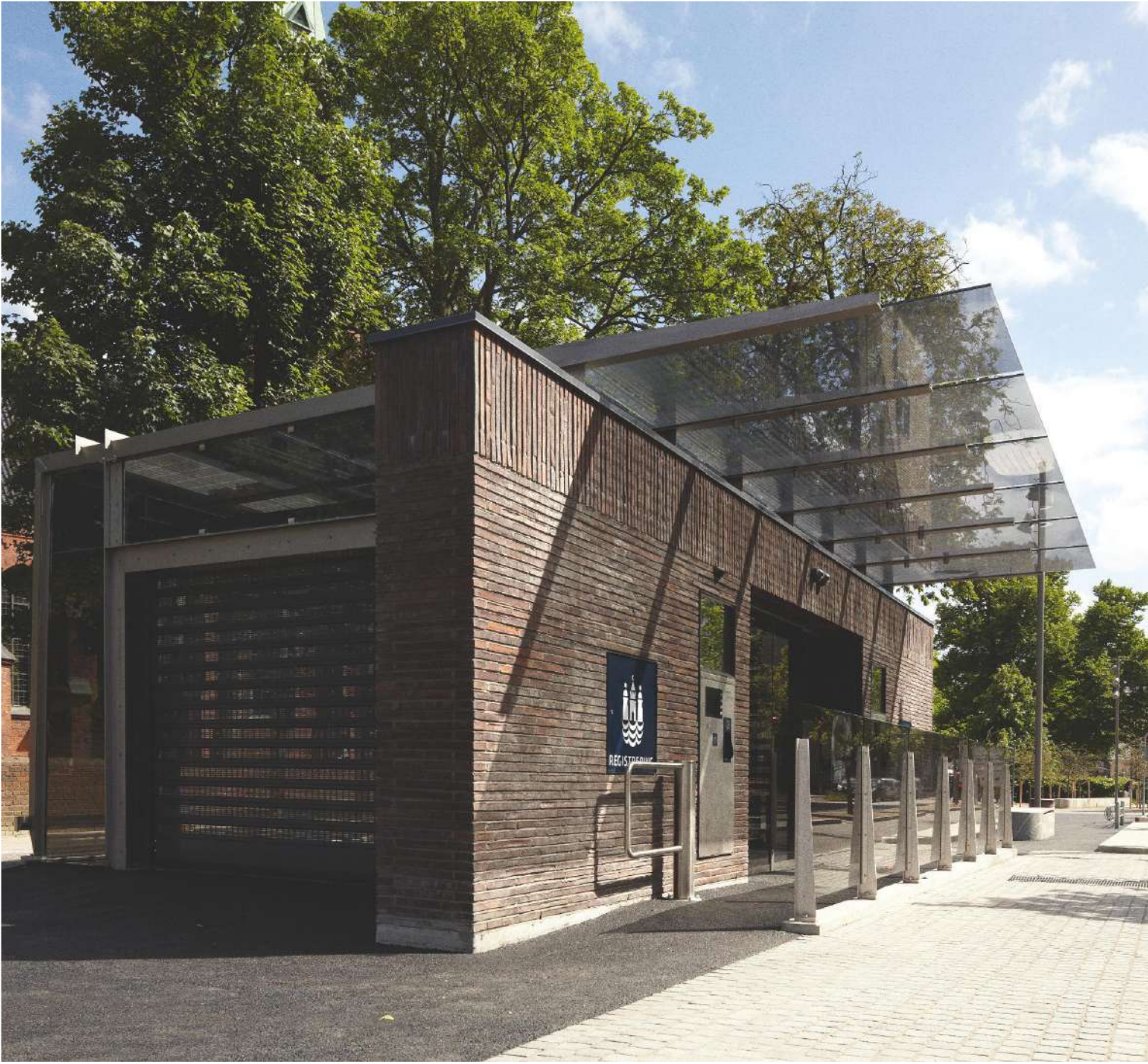
Elevatorboksene til de nye parkeringsanlæg er udført med Kolumba – i øvrigt første gang stenen er brugt som standerskifte. Kolumbas lange, flade format accentuerer murens længderetning og bidrager samtidigt til elevatorboksens designkvalitet.
