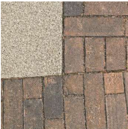
Den nye klinke har formatet 300x97x65, hvor kop går op i sidelængde. De mange overgange i havens belægninger er derfor udført næsten uden, at der skulle skæres i stenene.
