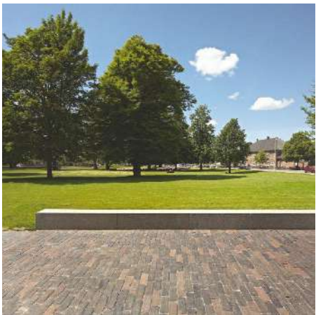
Den nye klinke har formatet 300x97x65, hvor kop går op i sidelængde. De mange overgange i havens belægninger er derfor udført næsten uden, at der skulle skæres i stenene.
