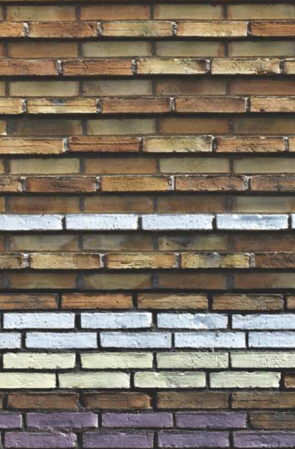
Petersen Tegl fremstillede mange specialsten til den kunstneriske udsmykning, blandt andet glaserede sten i mange forskellige farver.
