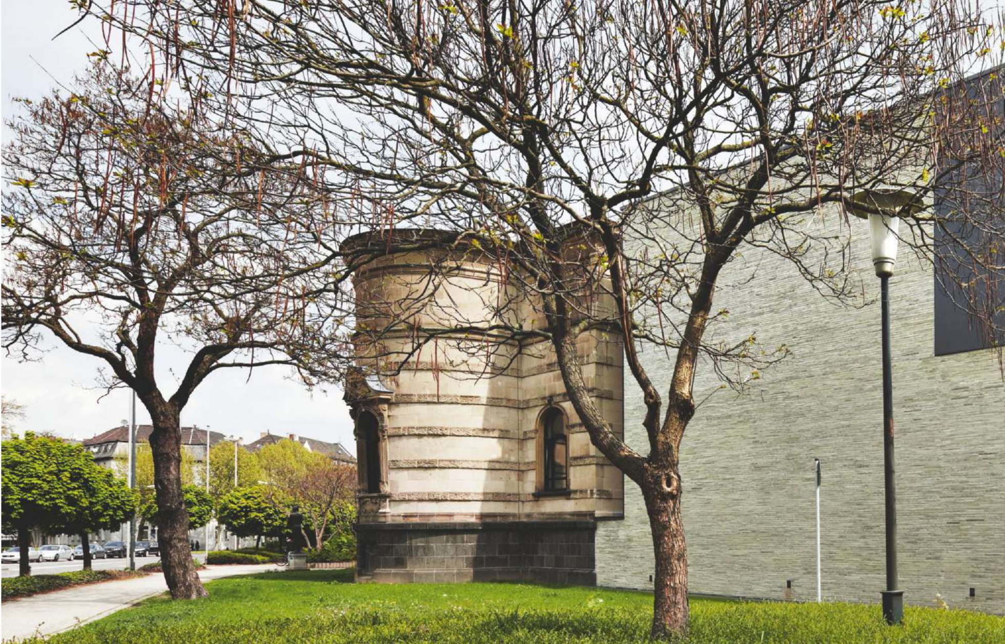
Det samlede anlæg kan aflæses både som en sluttet helhed og som to bygninger, der fører en dialog med hinanden.
