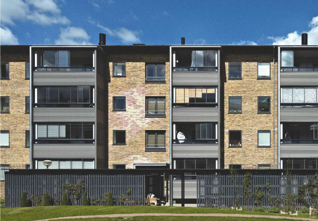
Murværket varierer gennem hele byggeriet med forskellige mønstre, relieffer og farvesammensætninger. En fællesnævner er husenes base, der med en mørk mørtel er gjort visuelt tungere.
