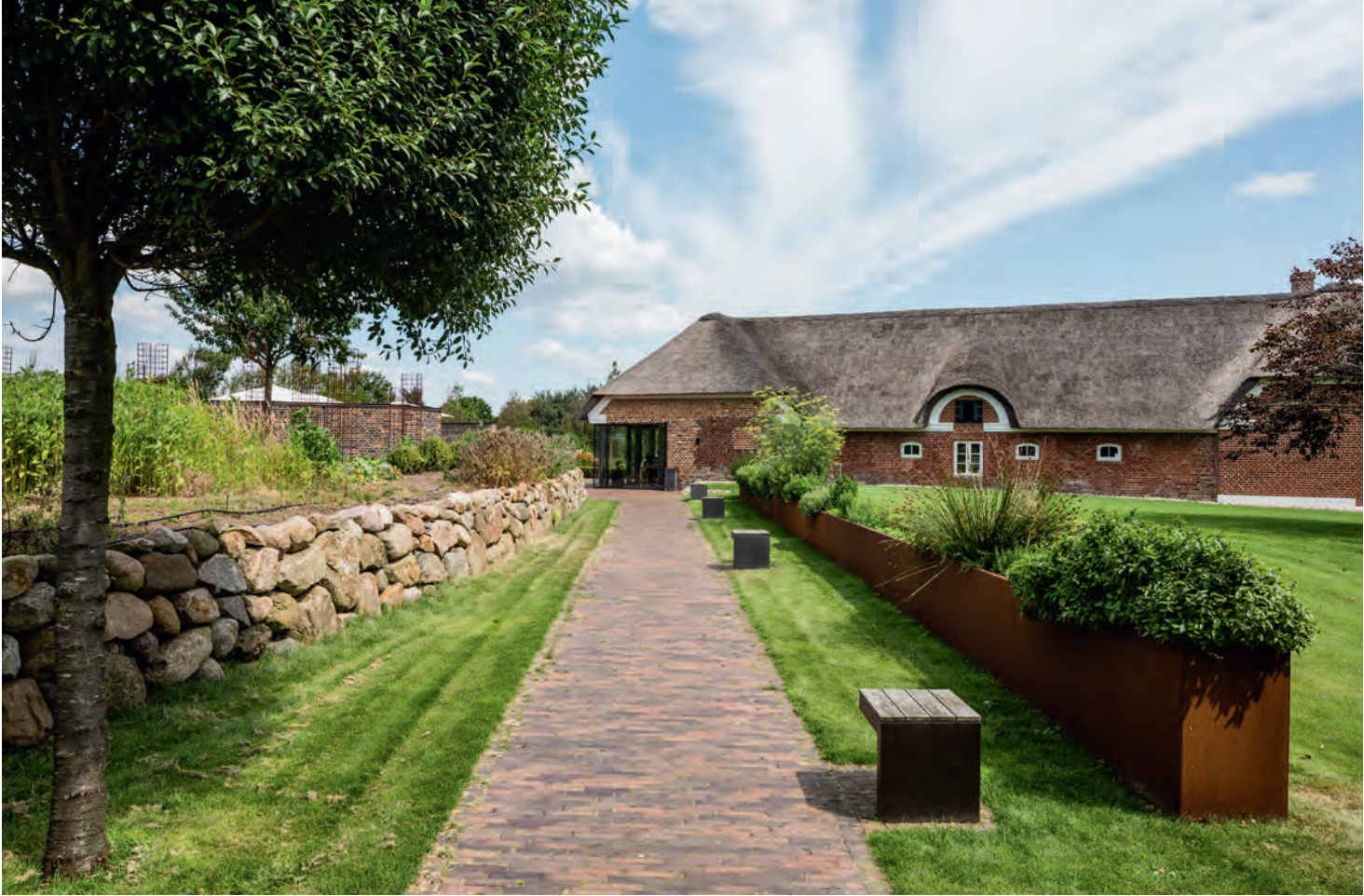
Henne Kirkeby Kro er opført omkring 1790 som grundmuret gård i håndstrøgne, røde teglsten og med afhvalmede stråtage.
