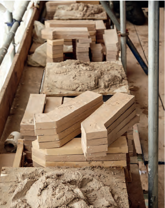
For at løse de mange, krævende detaljer blev der i alt fremstillet 85.890 Kolumbasten i 27 speciallavede udgaver. Det havde ikke været muligt med en industrifremstillet sten.
