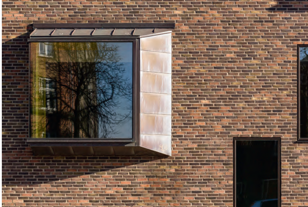
Den nye, firetages bygning er karakteriseret af kobberinddækkede karnapper på husets nord- og vestfacader.
