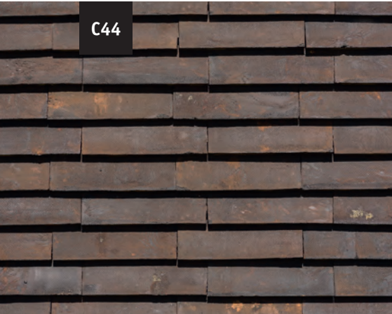
Petersen Cover har indgået i Petersens standardsortiment siden 2013. Stenen findes i 14 standardfarver og to størrelser: 528mm x 170mm x 37mm og 528mm x 240mm x 37mm. Derudover udvikler teglværket gerne specialformater og farver. Fotos: Anders Sune Berg
