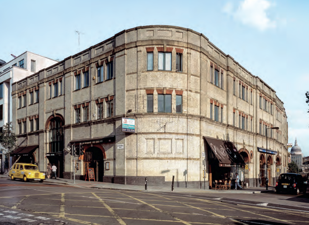
Den oprindelige bygning på stedet blev opført sidst i 1800-tallet som stald i flere etager for metroens arbejdsheste.
