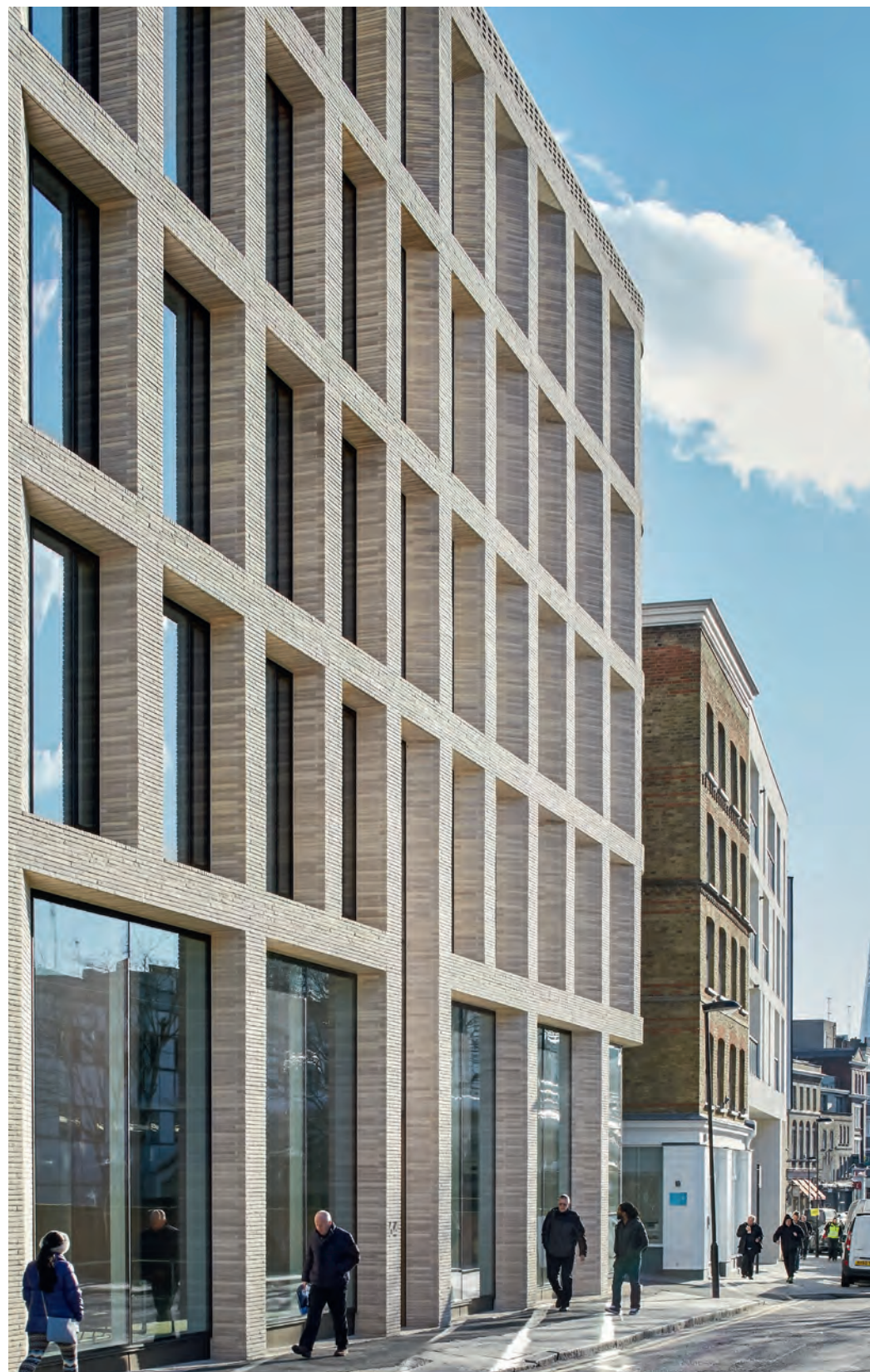
For at undgå bærende facader er der anvendt overliggere over alle bygningsåbninger. Overliggerne, der er produceret i England, er isat hele Kolumbasten og fuldstændig integreret i facaden.
