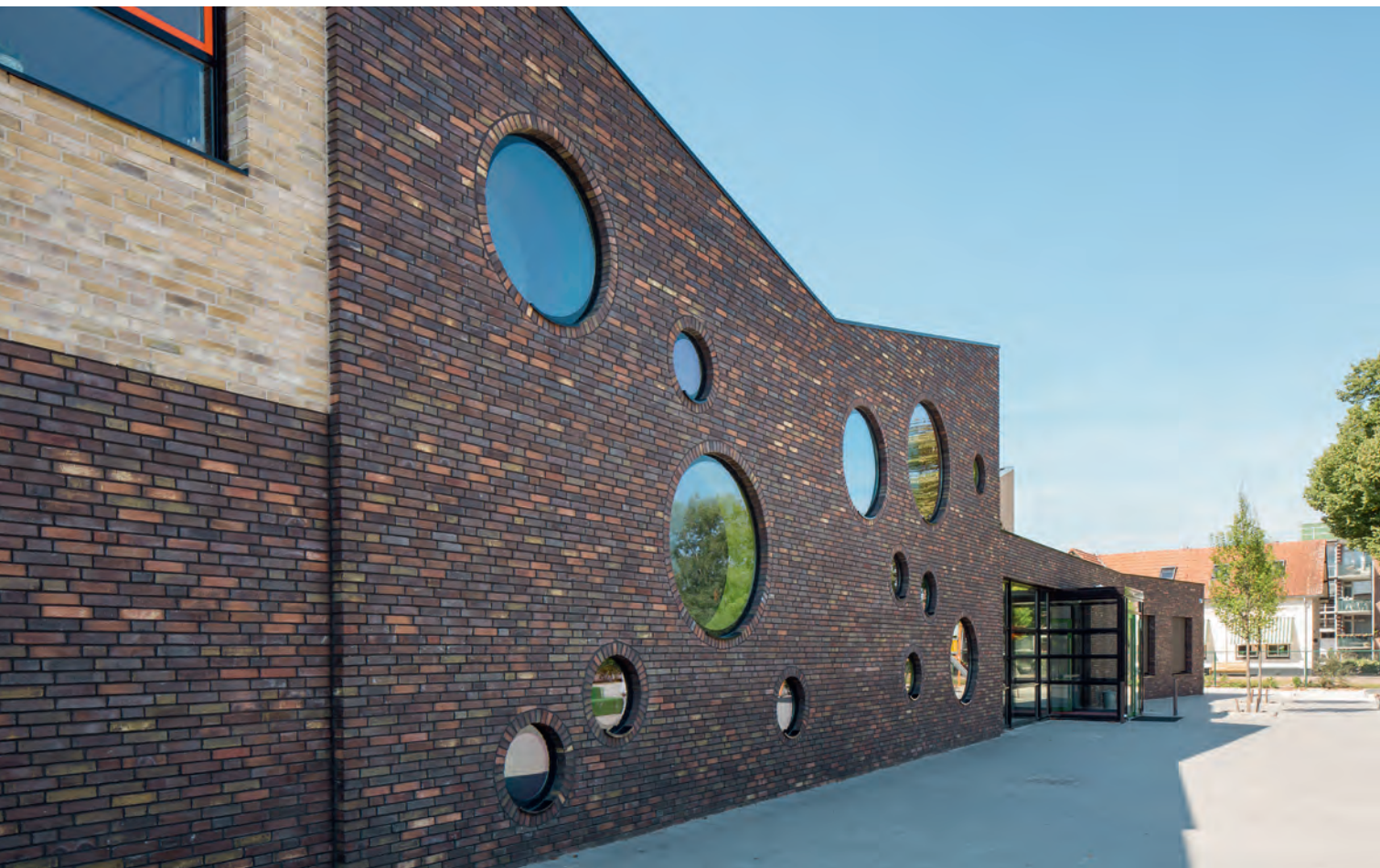
Bag bygningens nordfacade med de boblende, runde vinduer findes skolens mindre bevægelsesrum.
