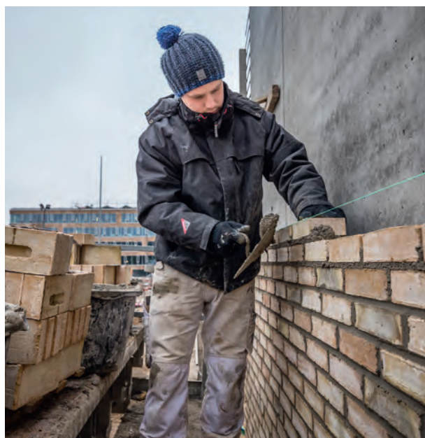
Mureren kan tage direkte fra paller med forblandede sten. Billedet er taget på byggepladsen for det psykiatriske hospital i Slagelse, der indvies i august. Hospitalet er tegnet af Karlsson arkitekter og Vilhelm Lauritzen arkitekter, der vandt konkurrencen om det store projekt i 2013. Fotos: Anders Sune Berg
