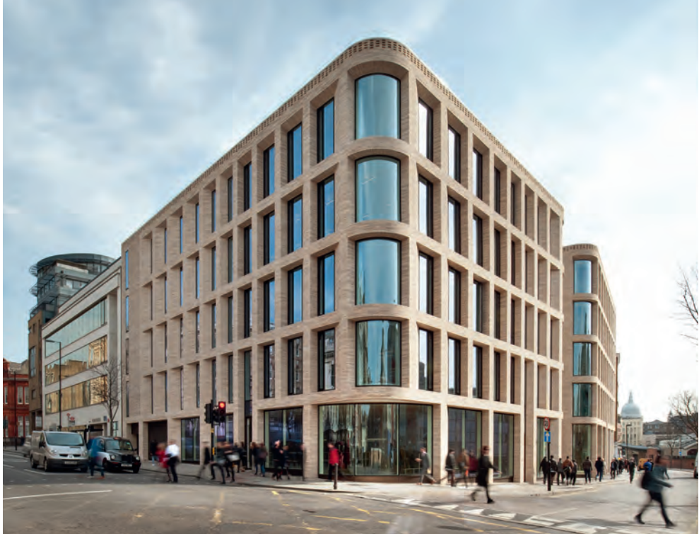
De tilbagetrukne vinduer reducerer etagearealerne og dermed udnyttelsesgraden, men er et absolut plus for facaden, som tilføjer et markant relief.
