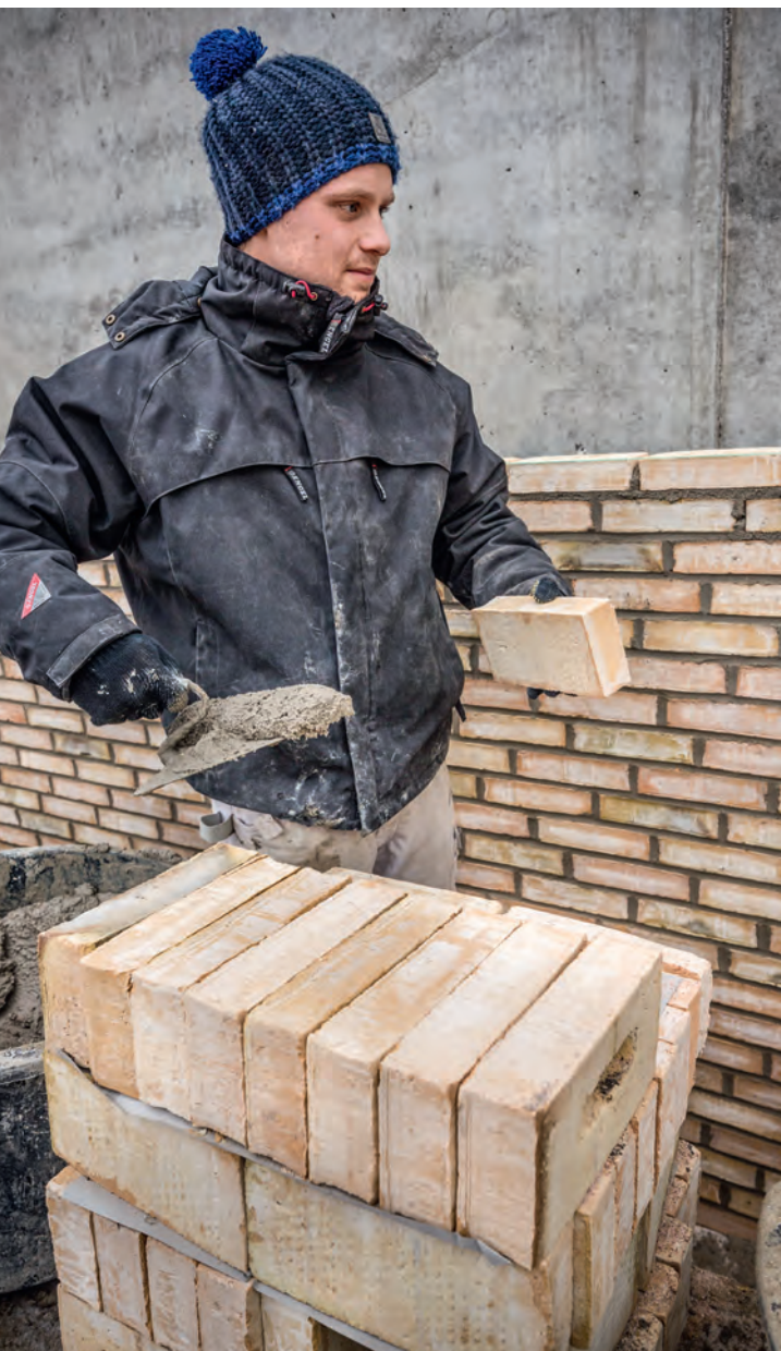
Mureren kan tage direkte fra paller med forblandede sten. Billedet er taget på byggepladsen for det psykiatriske hospital i Slagelse, der indvies i august. Hospitalet er tegnet af Karlsson arkitekter og Vilhelm Lauritzen arkitekter, der vandt konkurrencen om det store projekt i 2013. Fotos: Anders Sune Berg
