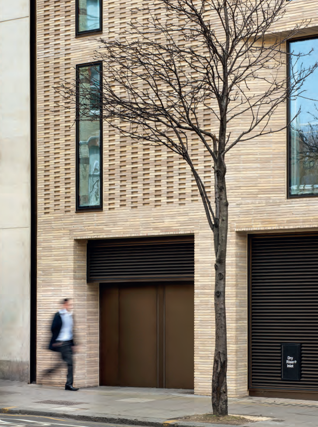
De håndlavede Kolumba er unikasten, der alle vrider og bukker sig en anelse i fremstillingsprocessen. Når de skubbes ud af formen opstår der tillige en tynd læbe langs den ene kant. I Tunmillbygningen er alle sten placeret med læben nedad – en omhu i detaljen, som yderligere forstærker facadens ensartet, uensartede udtryk.
