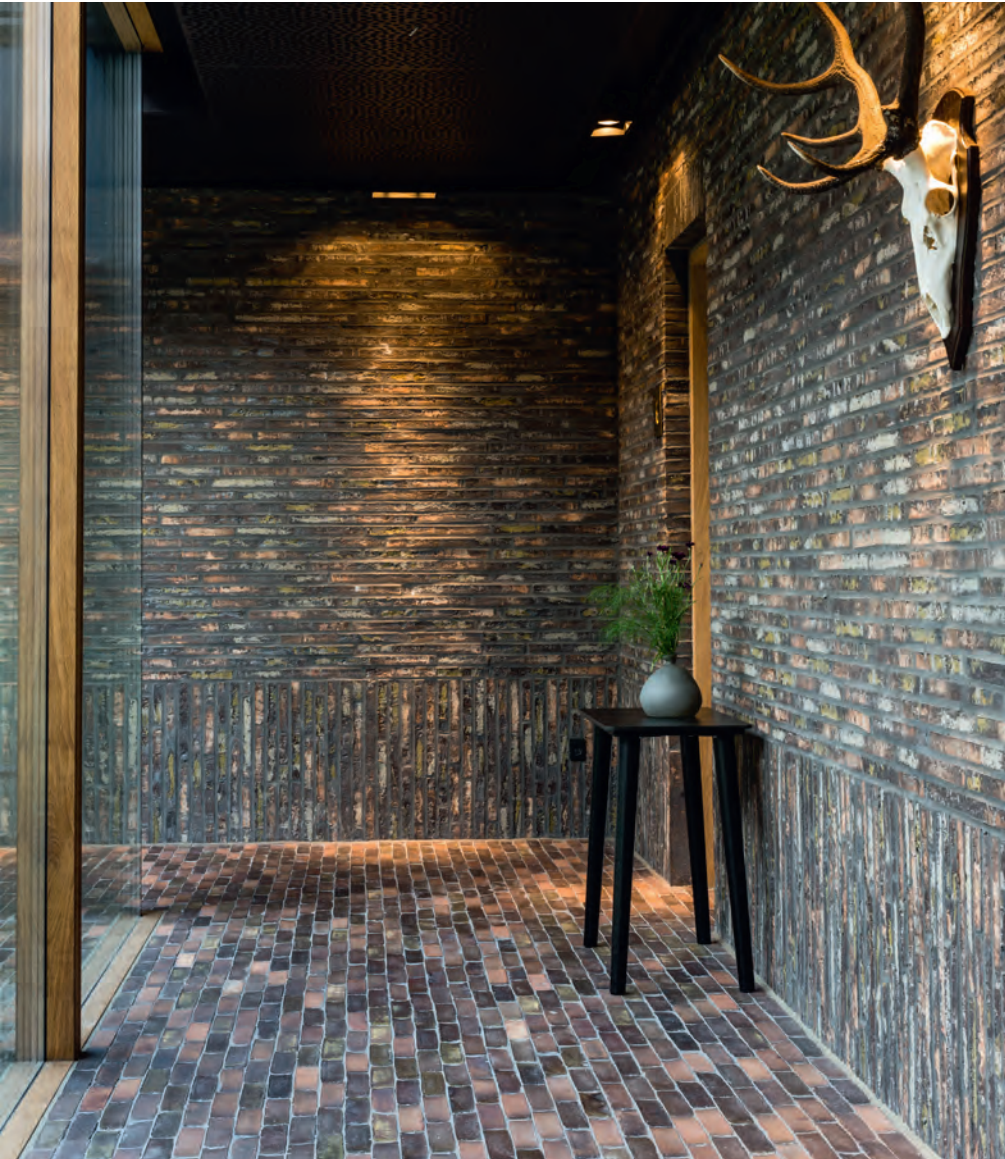
Husets indre og ydre udgør et hele. Facadernes Kolumbasten er trukket ind og udgør vægge, og gulvene er belagt med den klinkebrændte D48.
