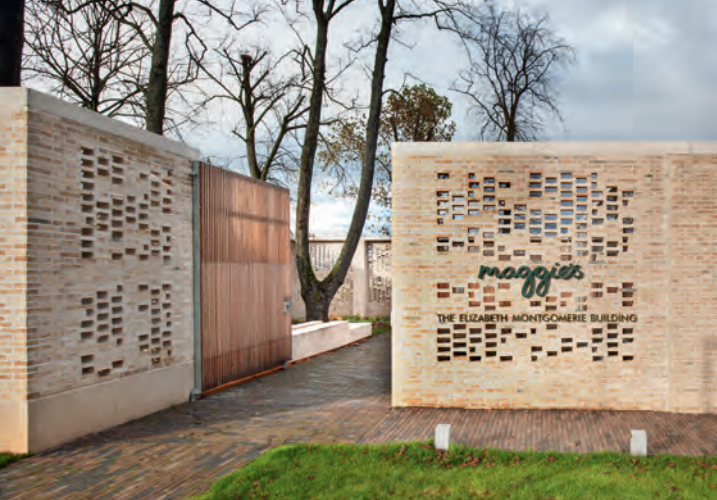
Hovedindgangen til Maggie's Centre leder gæster ind i anlæggets forgård gennem en åbning i muren.
