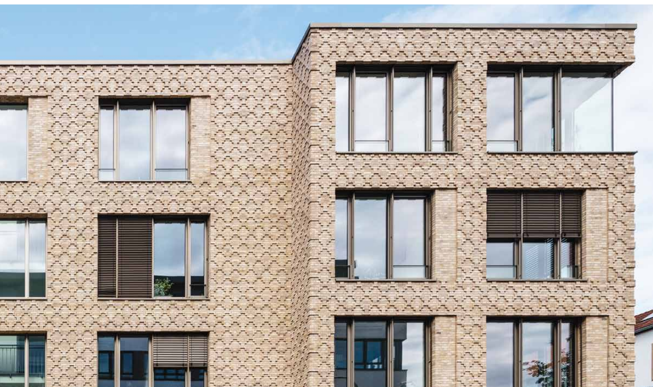
Lotter Strasse, Osnabrück, Lorenzen Mayer Architekten, 2016. Photo: Paul Kozłowski.
