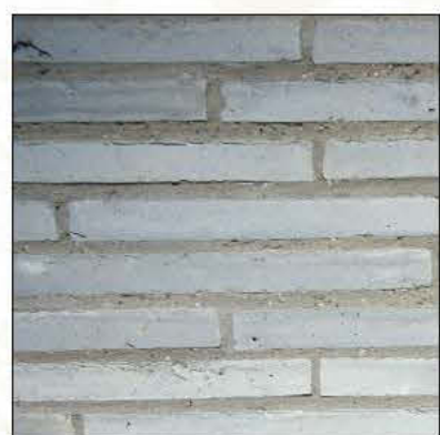
Fletmurværket, Zumthor har døbt det "pull-over", lavet med håndlavede, homogene lysegrå sten fra Petersen Tegl Egersund.
