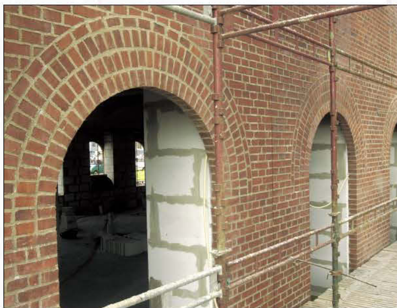
Fint udspændte buestik og krydsforbandt fra J.O. Pedersen-murerne på Islands Brygge. Arkitektur af PLH Arkitekter A/S. Sten: Petersen Tegl D33.
