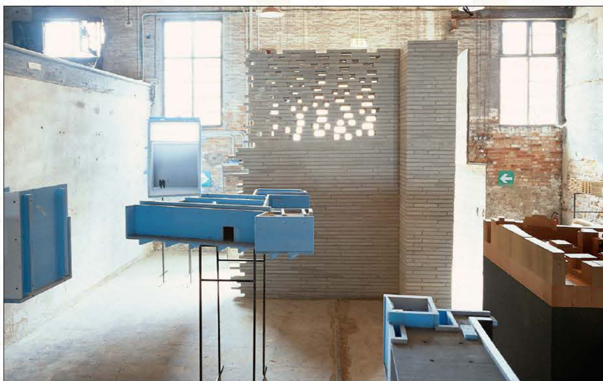
Fletmurværket, Zumthor har døbt det "pull-over", lavet med håndlavede, homogene lysegrå sten fra Petersen Tegl Egersund.
