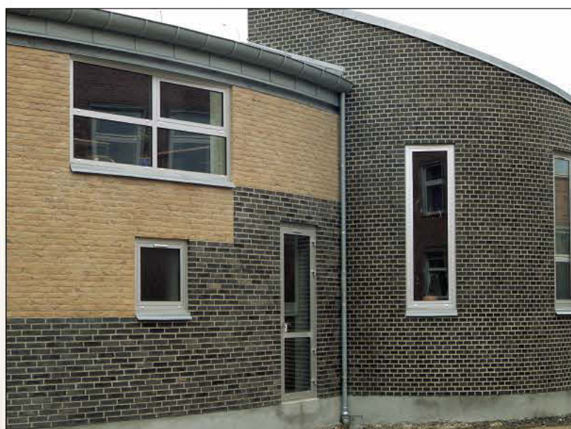
Detaljeret murværk med lyse fuger: Den håndstrøgne D1 er et transparent kontrastpunkt til klinken D55. Bemærk kopforbandtet der er valgt til den stærkt rundede apsis.
