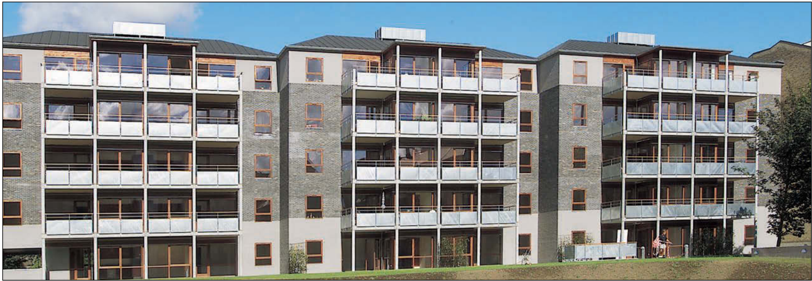
Howitzvej 43-47 er et projekt fra Høpfner A/S og et eksempel på et stramt styret boligbyggeri i høj kvalitet til lavere pris.
